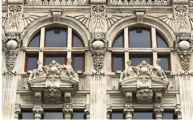
Görsel 5: Frej Apartmanı giriş cephesinden ayrıntı.
