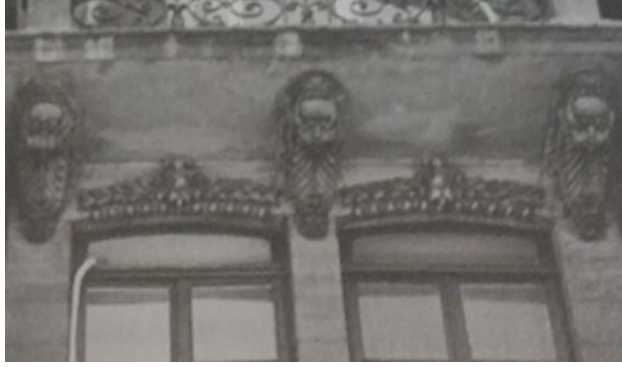
Görsel 5: Assicurazioni Generali Han kuzey cepheden ayrıntı.
