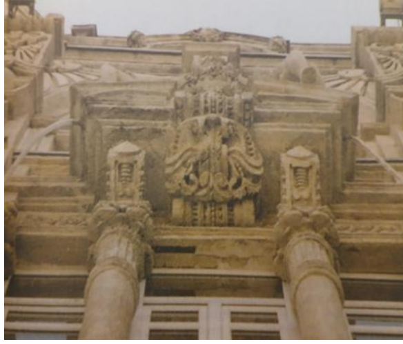
Görsel 10: Frej Apartmanı kuzey cepheden ayrıntı.
