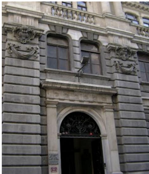
Görsel 3: Assicurazioni Generali Han kuzey cepheden ayrıntı.
