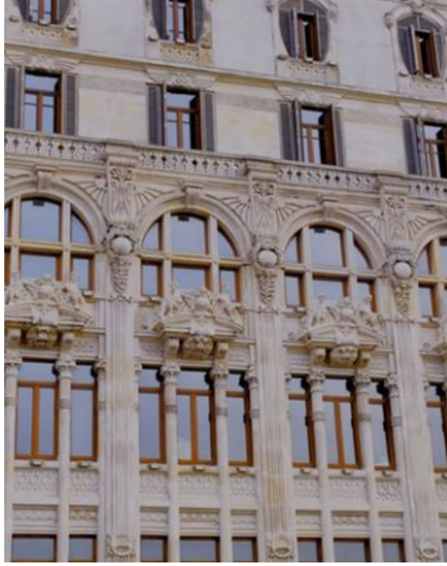
Görsel 4: Frej Apartmanı giriş cephesinden ayrıntı.
