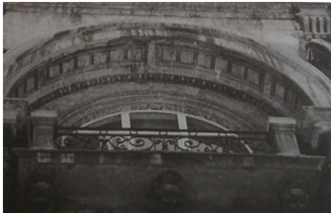
Görsel 6: Assicurazioni Generali Han kuzey cepheden ayrıntı.
