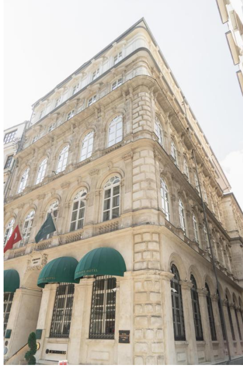
Görsel 1. Sümerbank Binası güney ve doğu cepheleri
