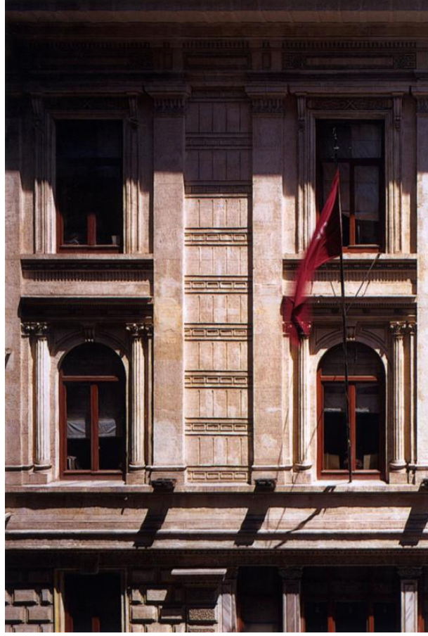
Görsel 3. Demirbank Binası pencere ve plaster düzeni
